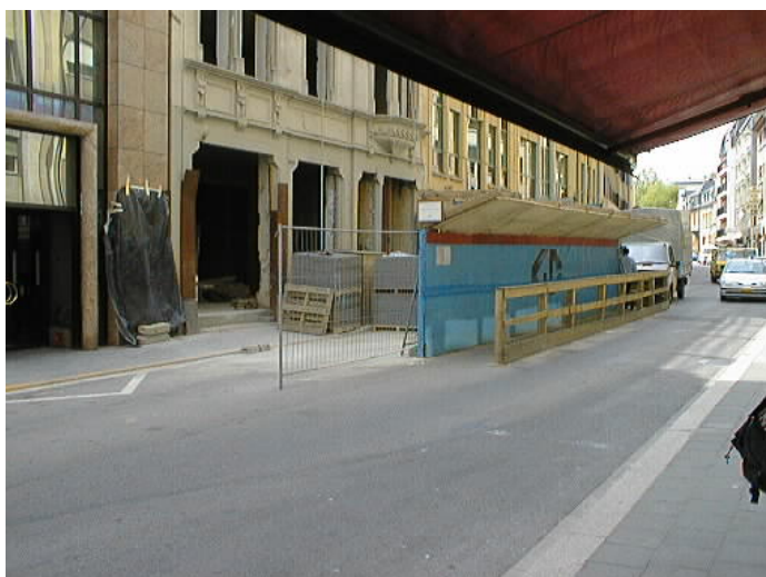
Aire et accès d'approvisionnement du chantier
